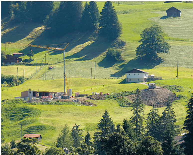
Construction de résidences secondaires sur la verte prairie. Est-ce cela, une utilisation judicieuse et mesurée du sol suisse ?
